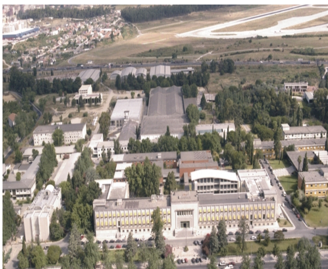
Figura 1 – Vista aérea do LNEC
