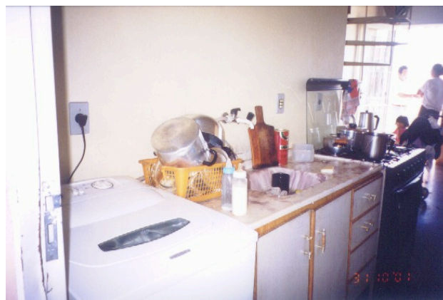
Figura 4 - Máquina de lavar roupas instalada no interior da cozinha; modificação, pelo usuário, das instalações hidrossanitárias. Fonte: Canto (2002).
