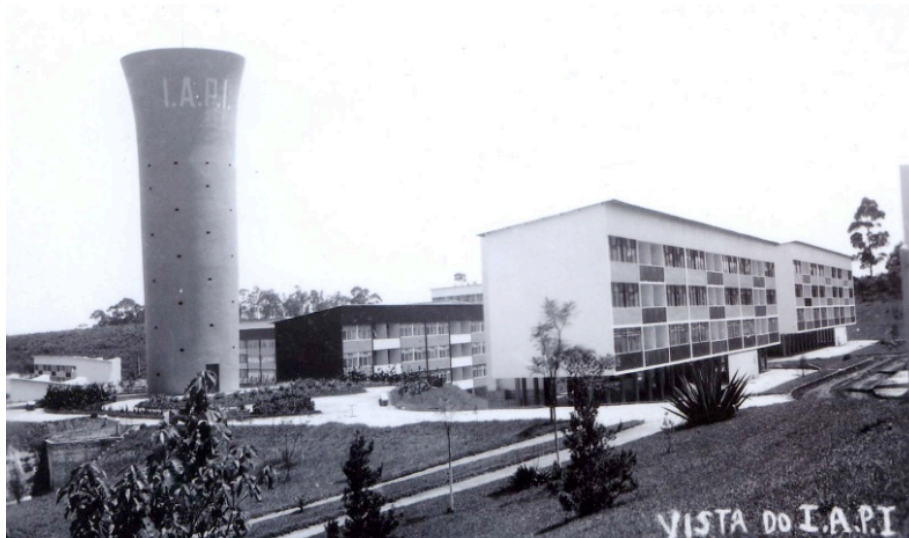
Fig. 5: Carlos Frederico Ferreira, Conjunto Residencial Vila Guiomar, Santo André, SP. Anos de 1940. Neste outro tipo de edifício a linguagem expõe o diálogo de Ferreira com seus contemporâneos do Rio de Janeiro: as amplas janelas, o telhado de única água, o bloco elevado sobre pilotis. MUSEU DE SANTO ANDRÉ DR. OCTAVIANO GAIARSA.
