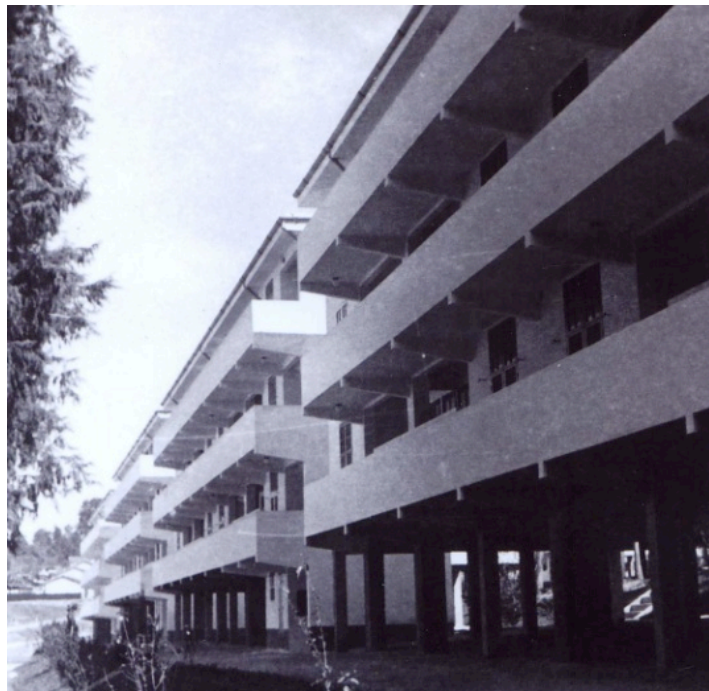
Fig. 4: Carlos Frederico Ferreira, Conjunto Residencial Vila Guiomar, Santo André, SP. Anos de 1940. Edifícios sobre pilotis, com destaque para as varandas longitudinais de acesso. MUSEU DE SANTO ANDRÉ DR. OCTAVIANO GAIARSA.
