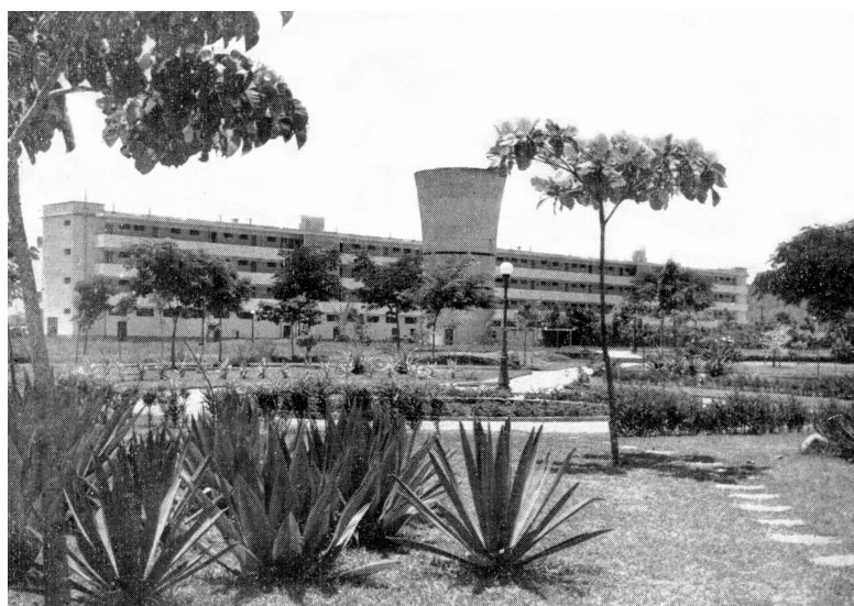
Fig. 13: Carlos Frederico Ferreira, Conjunto Residencial Operário em Realengo. Em primeiro plano a praça principal do conjunto e ao fundo o edifício coletivo com as varandas de acesso aos apartamentos. Destaque para a caixa d'água, símbolo do IAPI. ARQUIVO NACIONAL.
