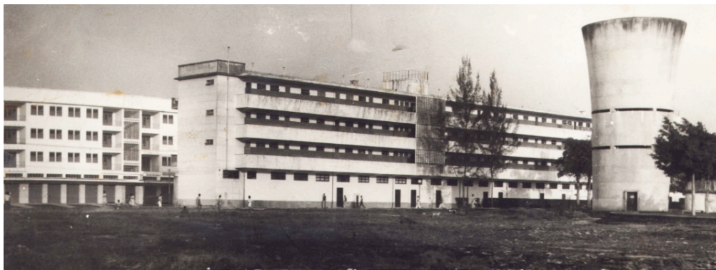
Fig. 7: Carlos Frederico Ferreira, Conjunto Residencial Operário em Realengo. Anos de 1940. Vista dos blocos com comércio no térreo, cuja implantação delimita a rua principal entre eles. Destacam-se no edifício em primeiro plano, as linhas horizontais definidas pela varanda que dá acesso aos apartamentos e no edifício em segundo plano, as linhas interrompidas conformadas pelas aberturas, janelas e varandas, das moradias. À direita a caixa d'água, que se tornou marca registrada, identificando vários dos conjuntos do IAPI. ARQUIVO NACIONAL, Rio de Janeiro.
