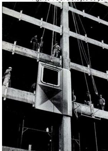
Figuras 4 e 5: Elevação do painel pré-fabricado/ Módulo da estrutura e fachada - edifício Alcoa, Pittsburgh.
