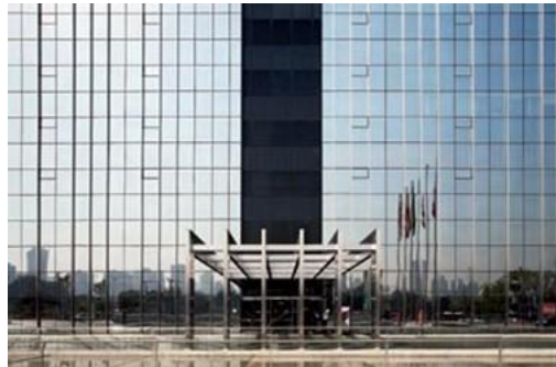
Figura 23: Entrada Principal do Prédio de escritórios
