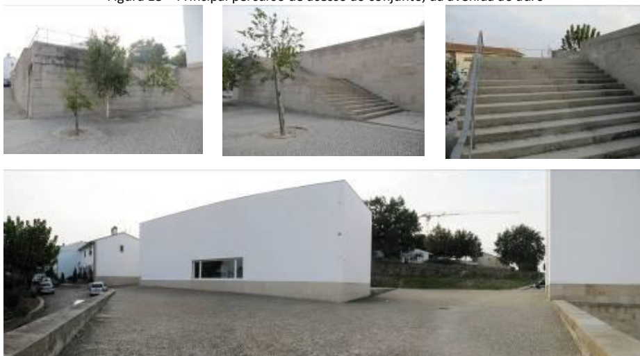
Figura 18 – Principal percurso de acesso ao conjunto, da avenida ao adro
