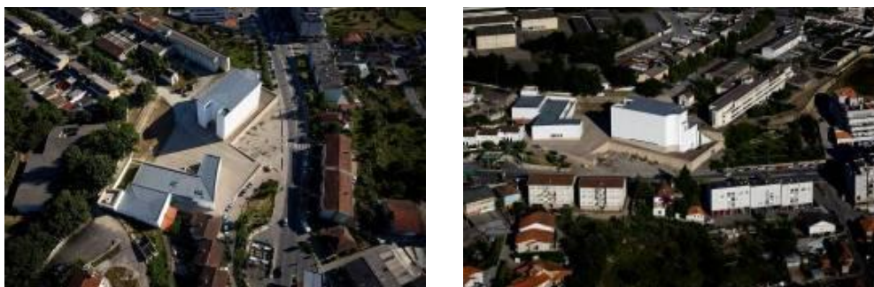
Figura 9 – Vistas aéreas da situação da Igreja de Santa Maria e do centro paroquial. Na parte superior da figura da direita encontra-se a casa da terceira idade, mencionada por Siza
