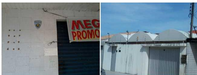
Figura 5: Estabelecimentos comerciais em que as fachadas principais exibem o selo do serviço de segurança particular e o fechamento completo do edifício com toldos e cercas elétricas
