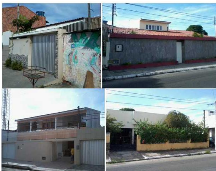
Figura 6: Residências no bairro do Poço, presença do completo fechamento da residência com grades, ausência de aberturas da fachada principal, grades de proteção com lanças nas extremidades e uso da vegetação para impedir a visibilidade do interior do imóvel ou possível invasão.
