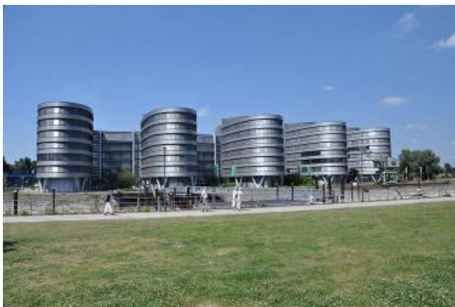
Figura 10. Os edifícios de escritórios “Cinco Barcos”, projeto do arquiteto britânico Nicholas Grimshaw.
