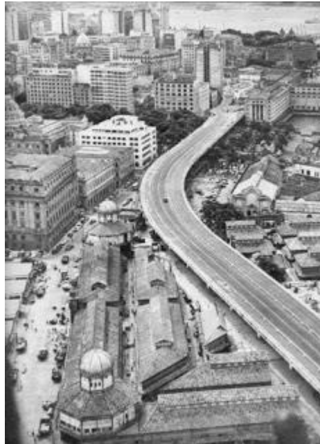
Figura 4: Elevado da Perimetral
