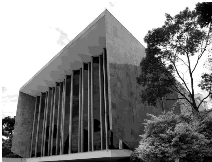
Figuras 4 e 5. Assembleia Legislativa do Paraná. Vista geral e detalhe interno de rampas. Fotos Helio Herbst, 2011
