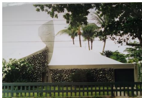
Figura 5 - Casa M. Guper, vista da rua.
