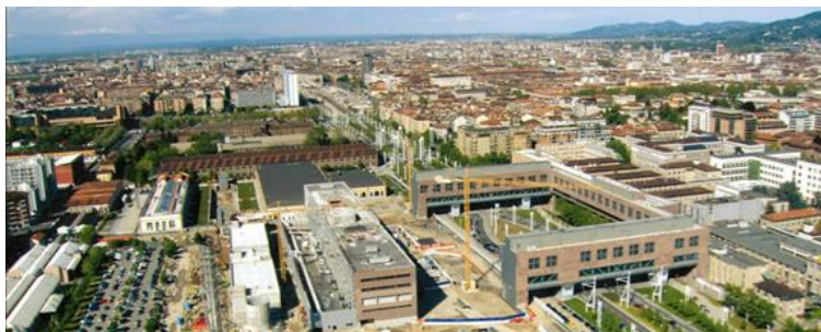
Figura 4. Vista do Eixo da Spina Centrale em obras, 2005
