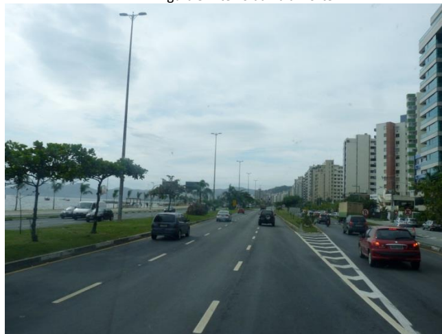
Figura 5: Aterro da Baía Norte
