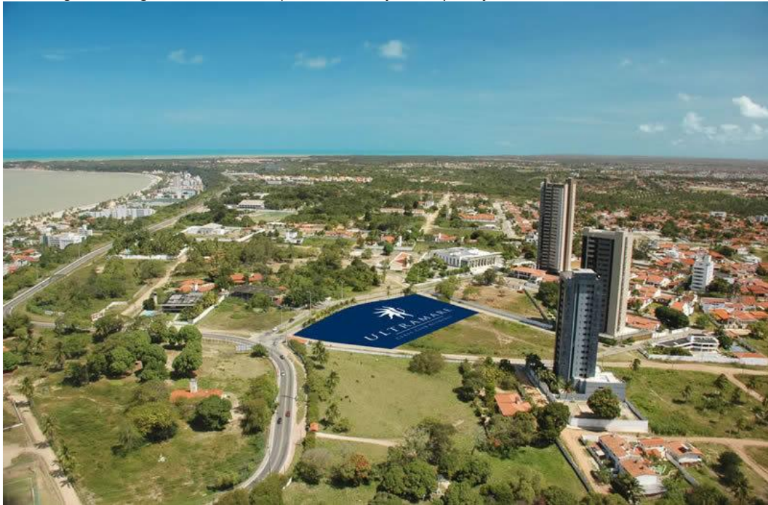
Figura 11: Imagem aérea do bairro Altiplano com indicação da implantação do Ultramare Class Club Residence.
