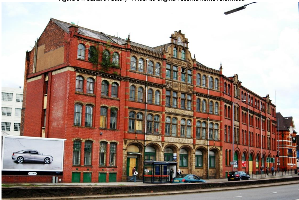
Figura 04: Custard Factory - A fábrica original recentemente reformada
