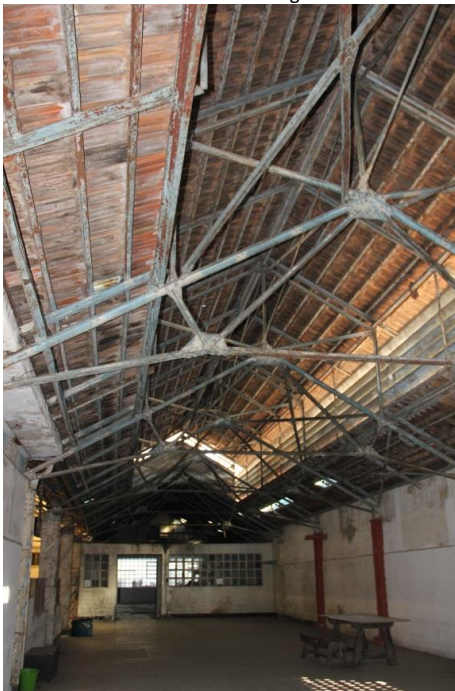
Figura 07: Fábrica de Chocolates Bhering – estado atual do imóvel
