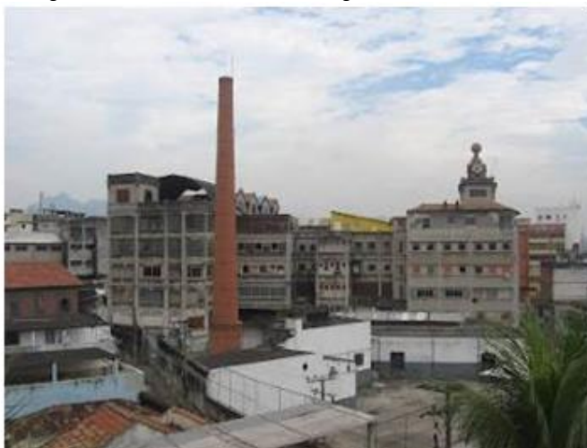
Figura 06: Fábrica de Chocolates Bhering – estado atual do imóvel
