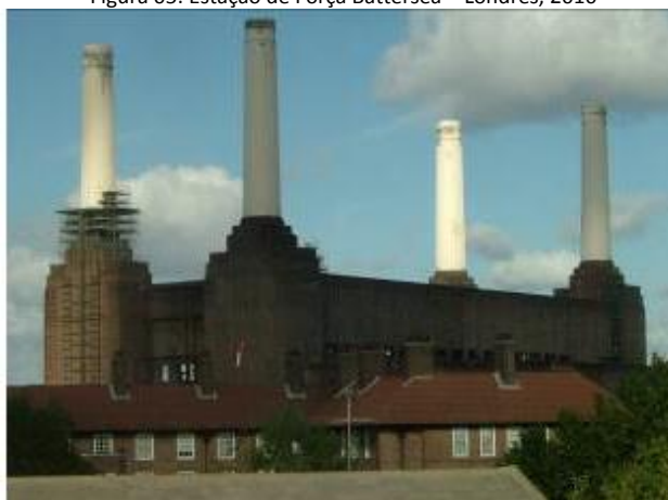
Figura 05: Estação de Força Battersea – Londres, 2010
