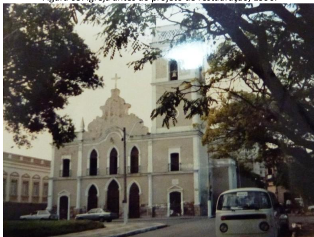
Figura 05: Igreja antes do projeto de restauração, 1990.
