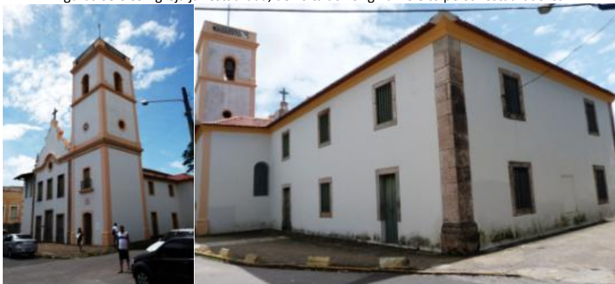
Figuras 08 e 09: Igreja já restaurada, de volta ao “original” eleito pelos restauradores.
