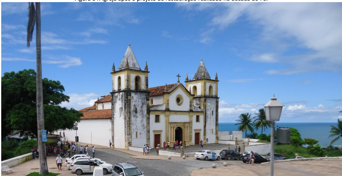
Figura 04: Igreja após o projeto de restauração realizado na década de 70.
