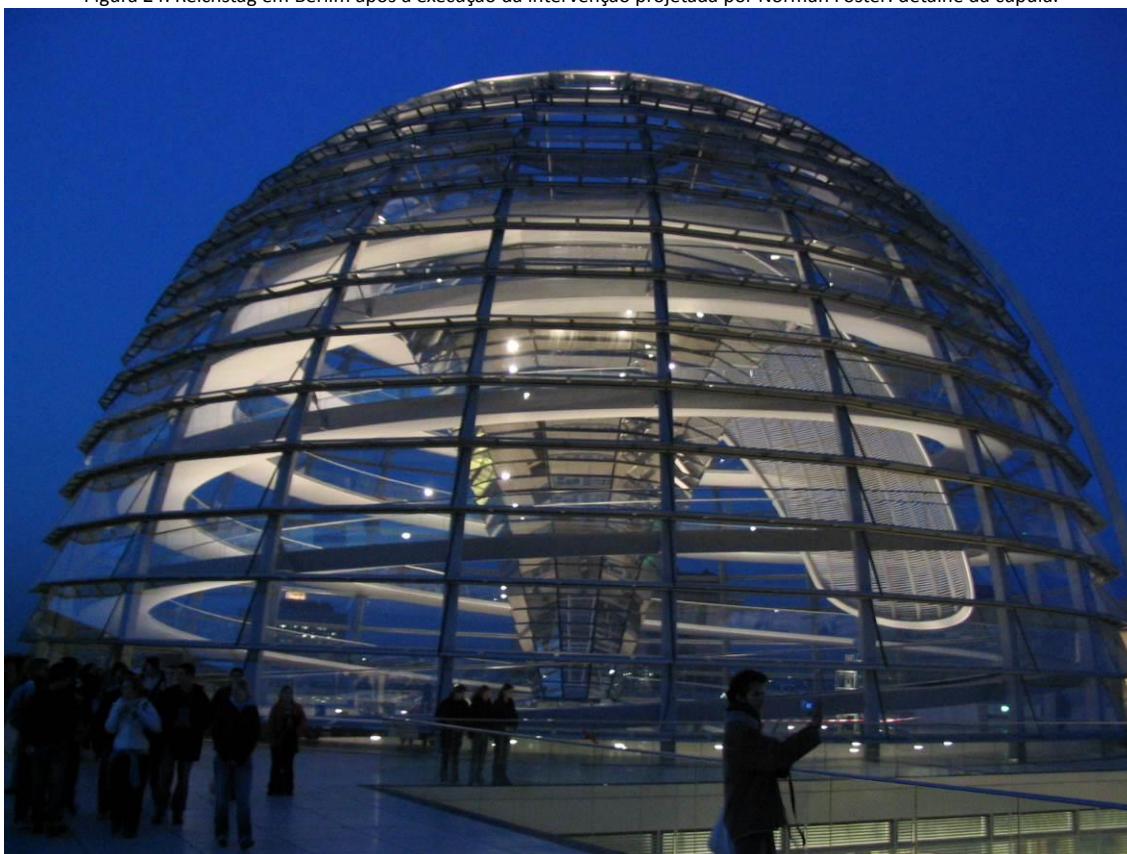
Figura 24: Reichstag em Berlim após a execução da intervenção projetada por Norman Foster: detalhe da cúpula.
