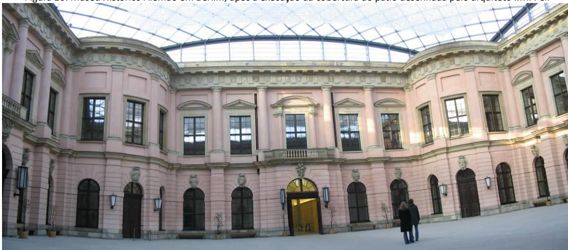
Figura 26: Museu Histórico Alemão em Berlim, após a execução da cobertura do pátio desenhada pelo arquiteto I.M. Pei.
