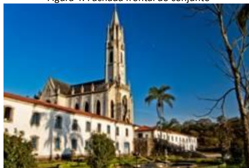
Figura 4: Fachada frontal do conjunto
