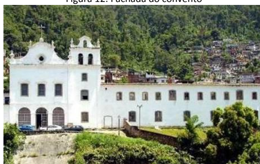
Figura 12: Fachada do convento
