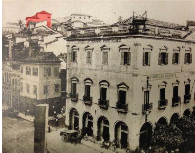
Figura 3 – Fotografia do antigo Liceu Literário Português, em área hoje ocupada pelo Edifício A Noite , com destaque para a casa do João Homem, na ladeira do João Homem. Fonte: Castro, Cesar, 1989, p.29.
