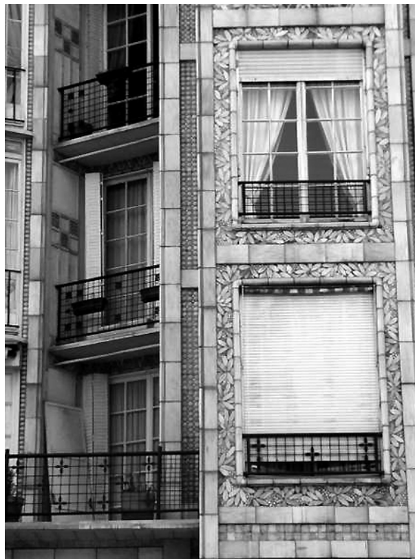
Fig. 03 - Vista parcial da fachada com os detalhes do balcão e revestimentos cerâmicos. (Disponível em < http://www.structurae.de/photos/paris25frank02.jpg >)
