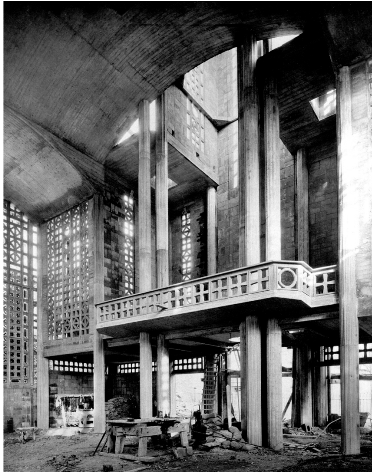
Fig. 05 - Vista interna da igreja em obras, com as colunas de dupla altura sustentando a laje do coro. (COHEN, 2002 p.178)
